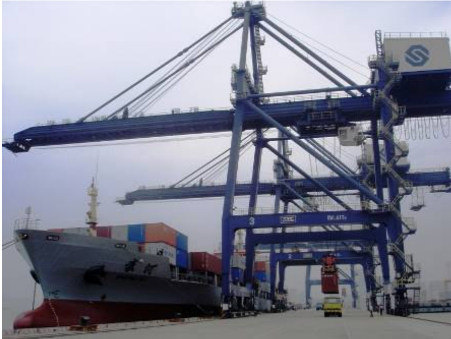
“盛河”轮靠泊汕头国际集装箱码头，标志着中远集运新东南亚航线 HSH 的正式运营
